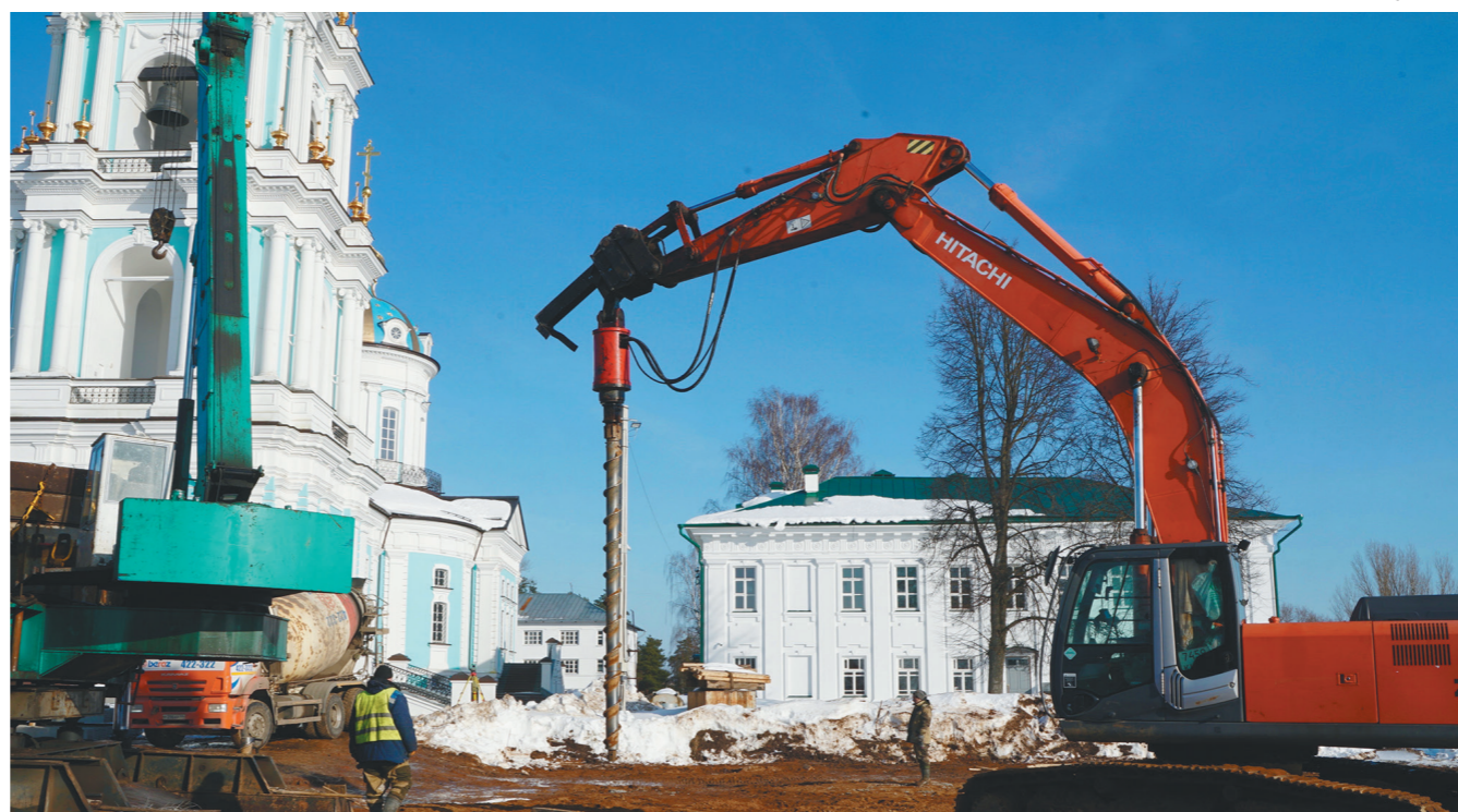
В основание Успенского собора забивали почти двести свай
