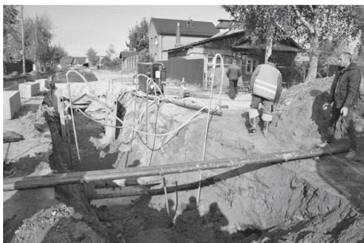
Ремонт тротуаров, обустройство газонов и оборудование ливневой канализации продолжают на улицах Космонавтов и Димитрова. Как подчеркнули строители, здесь есть сложности — близко подходят грунтовые воды. Это задерживает работы, которые
