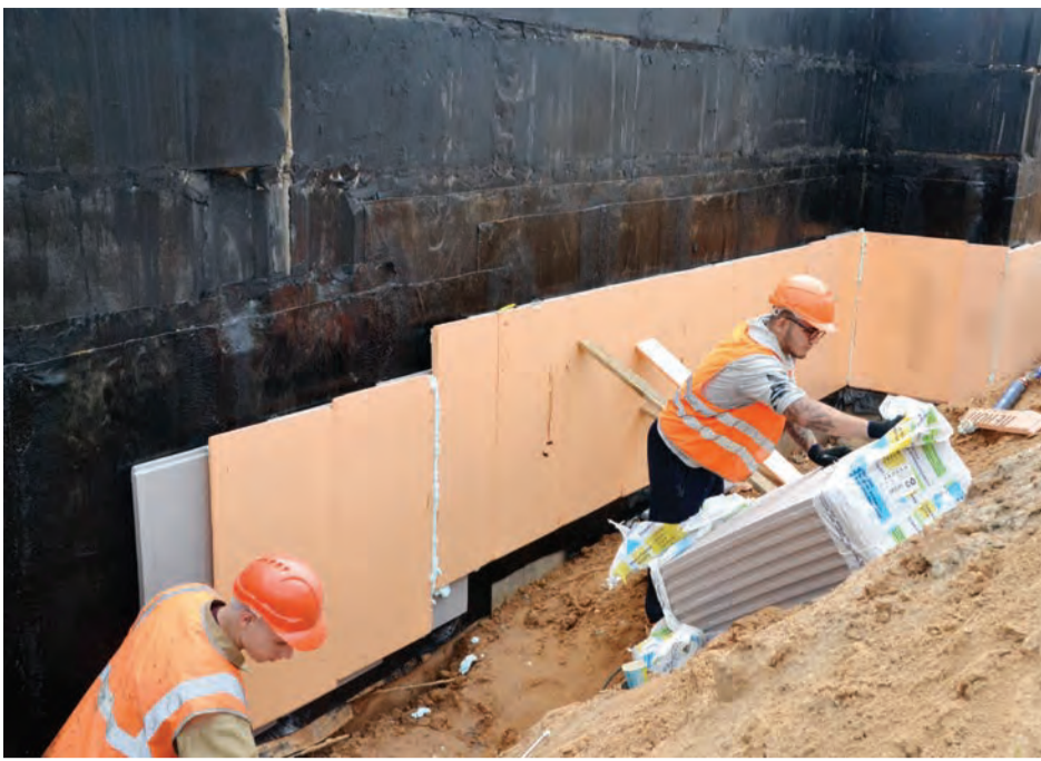
Бойцы стройотряда заняты важной работой – утеплением фундамента здания нового корпуса больницы
