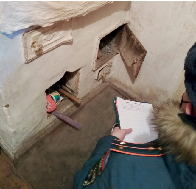
Сотрудник МЧС проводит осмотр печи
