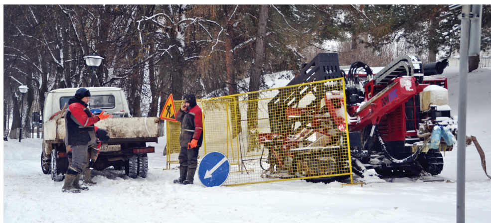
Строители начали прокладывать систему теплоснабжения
