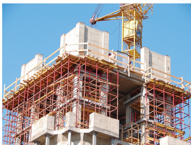
Работы идут на высоте 31 метр
