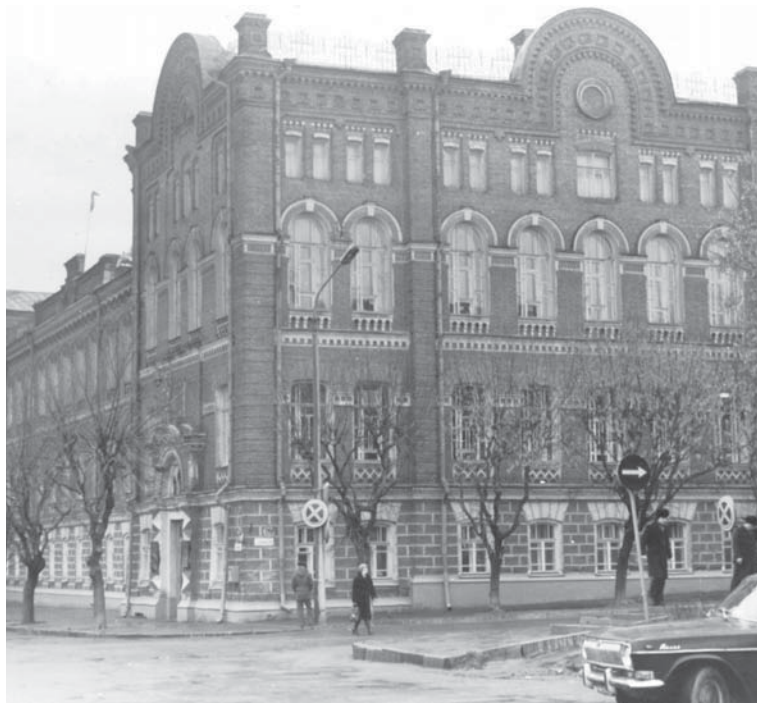
Здание Костромского обкома ВКП(б) – КПСС (ул. Дзержинского, 15)
