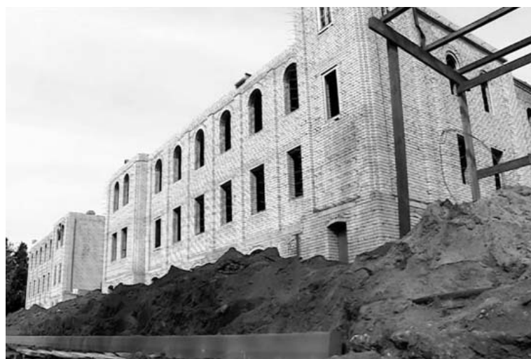
Строительство онкоцентра продолжается
