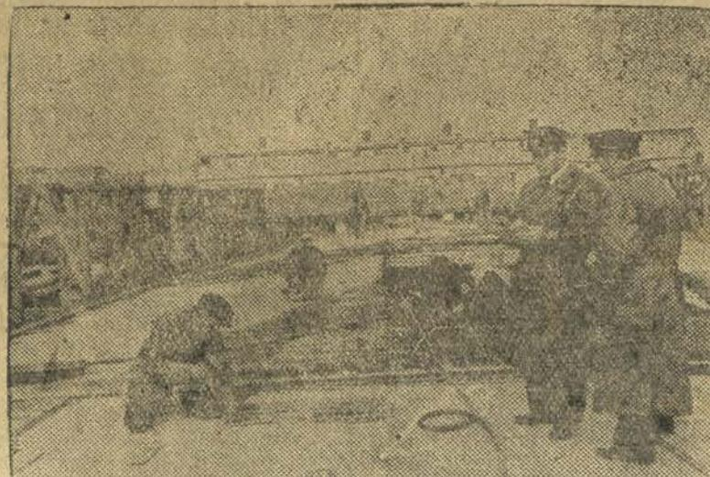
На Херсонском заводе «Судостроение» идет строительство железнобетонных танкеров. На снимке: арматурные работы на наливу танкера. (Фотохроника ТАСС).
