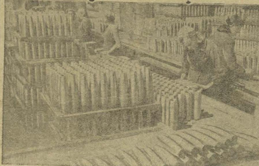
На Н-ском заводе (Сибирь). Изготовление снарядов.
