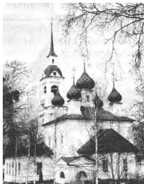
Христорождественская церковь. Фото 1982 г.
