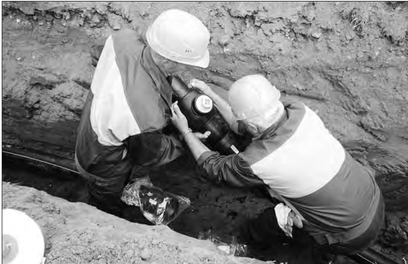
Бригада устанавливает подземный кран
